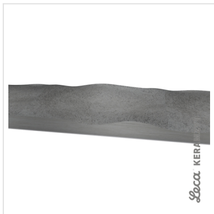
1. Strop żelbetowy nierówno wylany
