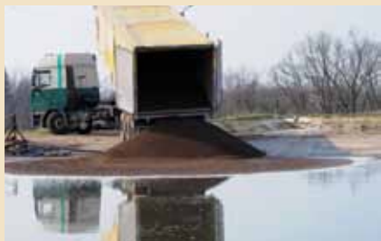
KERAMZYT wysypywano bezpośrednio na powierzchnię laguny.
