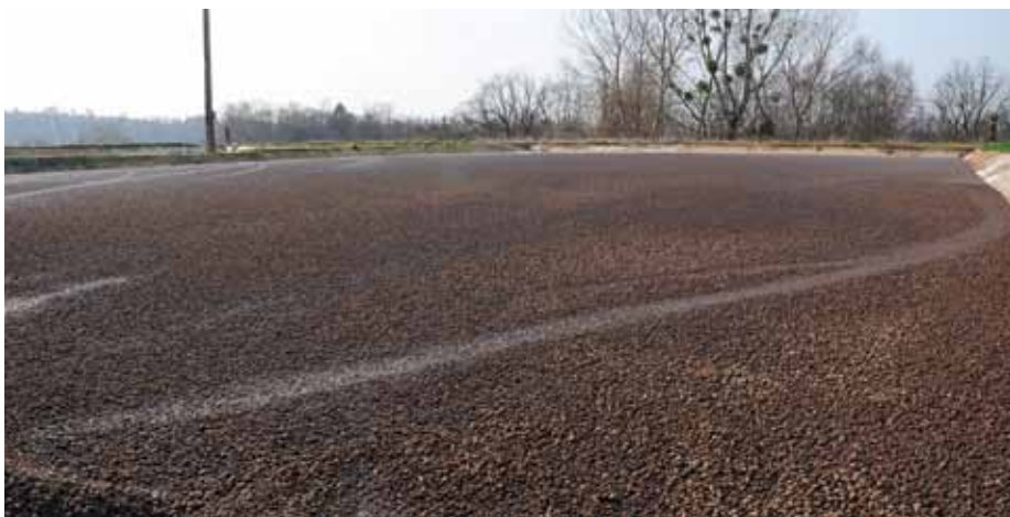
Nowo wykonana pokrywa pływająca z KERAMZYTU.
