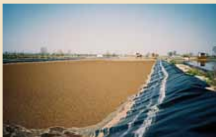
Realizowano kolejno pokrywy dla kilku lagun.
