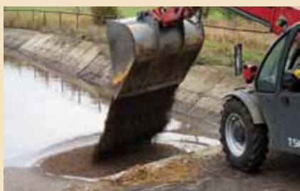
Prace wykonano z użyciem ładowarki.
