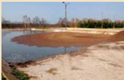
Kruszywo samoistnie rozplywa się po całej powierzchni.
