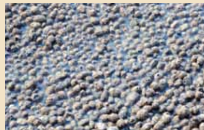
Wygląd pokrywy tuż po wykonaniu.
