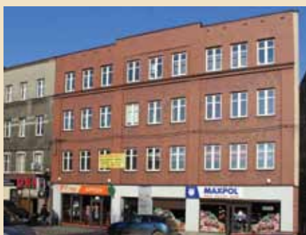
Budynek po remoncie.
