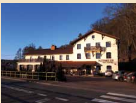
Obiekt po remoncie.
