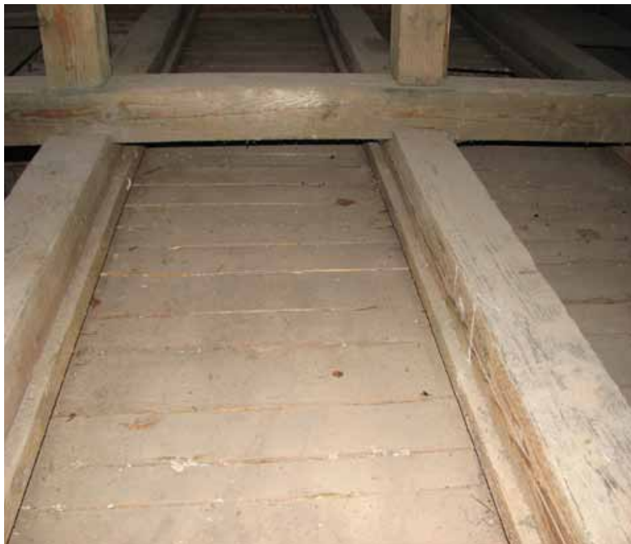
Typowy strop drewniany.
