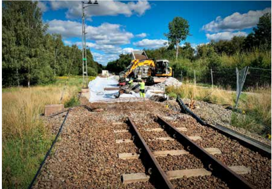
Pod keramzytobetonem umieszczono geowłókninę .
