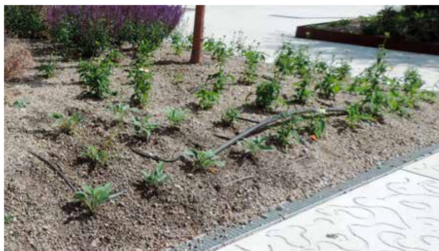
Do wykonania systemu podlewania terenu zielonego użyto węży wodnych o długości 6 km.
