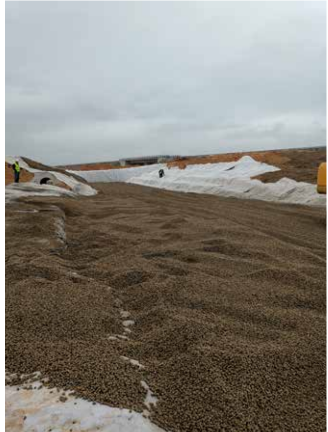
Wypełnienie Leca przed zagęszczeniem.
