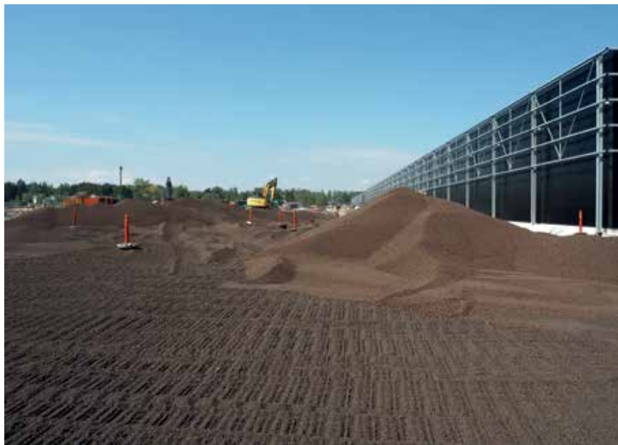
Grubość lekkiej warstwy wypełnienia Leca w konstrukcji placu waha się od 300 do 1200 mm.
