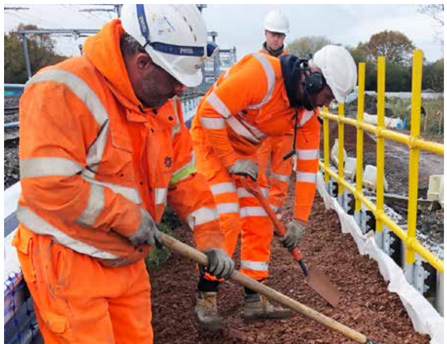
Keramzyt Leca® (10-20 mm) został dostarczony luzem naczepami typu Walking Floor
