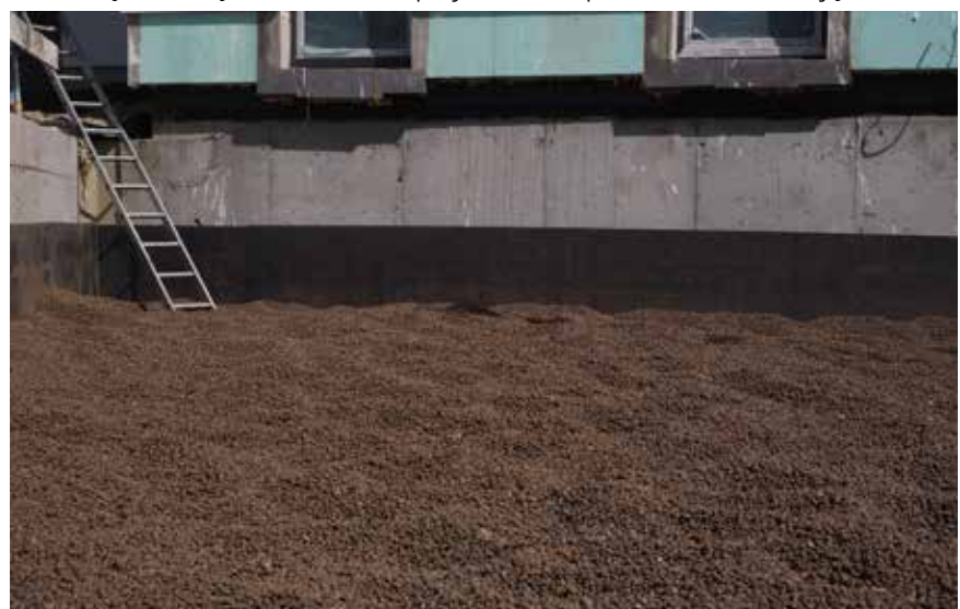
Wypełnienie w sąsiedztwie budynku i ścian oporowych.
