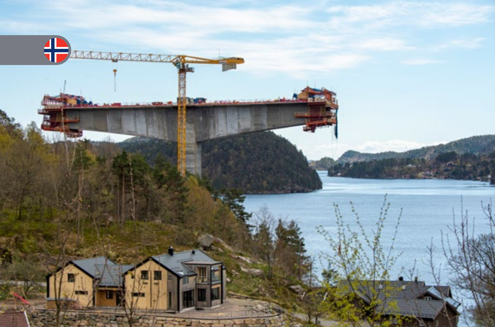
Wylewanie przęsła o długości 260 metrów w otwartej przestrzeni, 64 metry nad Trysfjorden, jest bliskie granicy możliwości.
