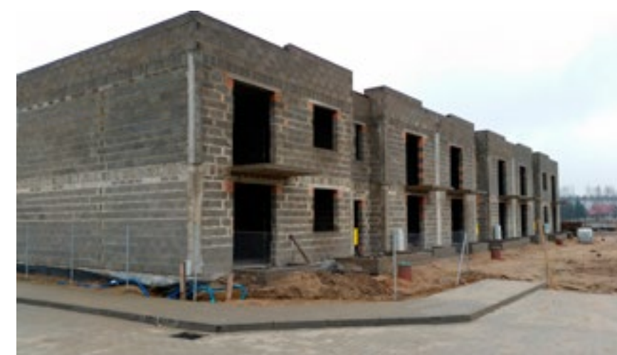
Budynek szeregowy w trakcie budowy
