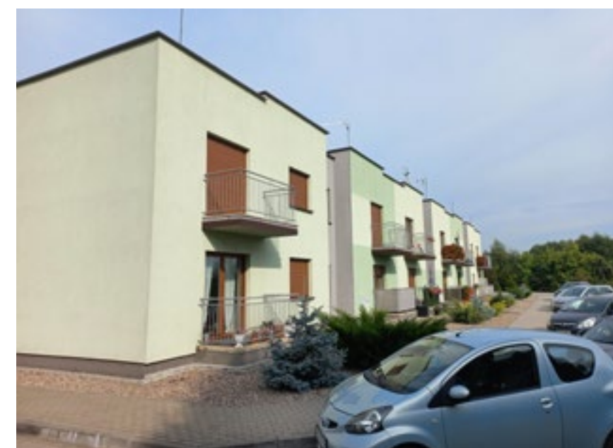
Gotowy budynek po pięciu latach użytkowania
