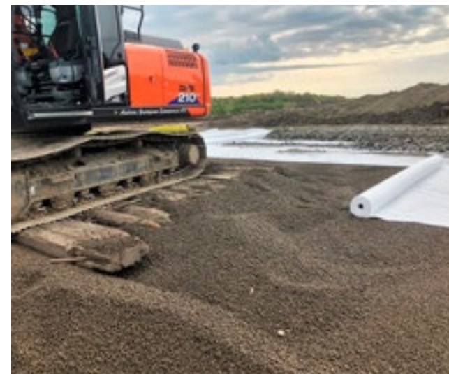
Geotkanina układana jest pod i na keramzycie.
