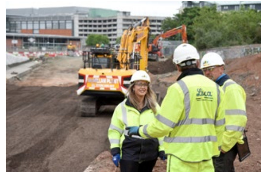
Leca KERAMZYT został wybrany jako lekkie wypełnienie pod torowiskiem tramwajowym, które przebiega pomiędzy dwiema istniejącymi ścianami oporowymi.
