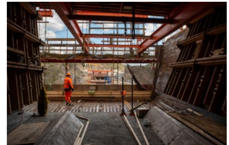
Wózki szalunkowe służą do wykonania jednorazowo pięciu metrów przęsła mostu, na każdym z czterech końców jednocześnie.
