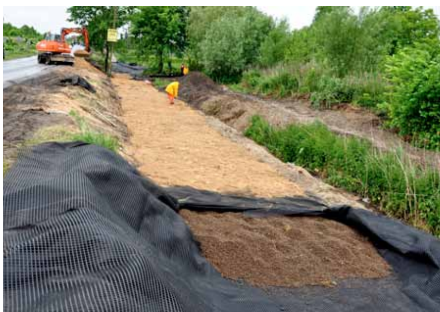
Przykrycie wypełnienia i podbudowa pod nawierzchnię
