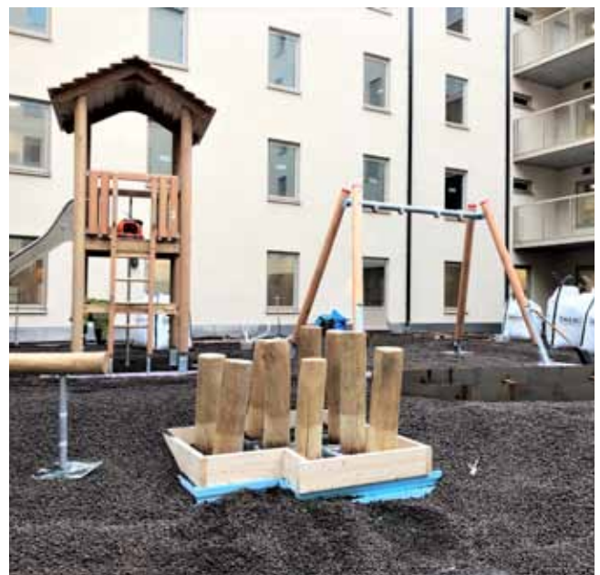
Dzięki zastosowaniu Leca® KERAMZYTU można znacznie zmniejszyć obciążenia na stropie
